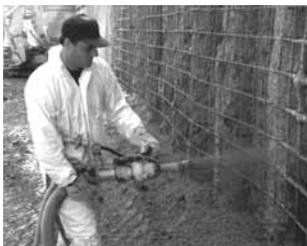
Hormigón proyectado (spritz-beton)
