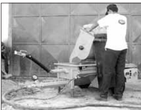
Baja altura de trabajo
