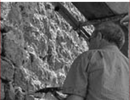
Relleno de juntas
