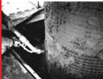
Proyección de mortero reforzado con fibras
