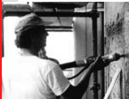
Aplicación de enfoscado tradicional o premezclado
