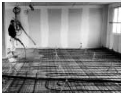
Bombeo de solados autonivelantes
