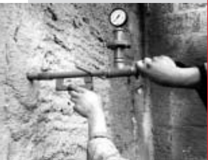
Inyecciones de lechada de cemento a presión controlada
