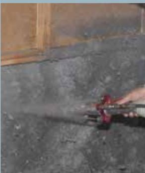
Kit ligero y compacto para flocado a alta presión, a utilizar con la máquina de soplado/insuflado de aislamiento de guata. La bomba deja automáticamente de funcionar cuando se cierra la válvula de agua.
